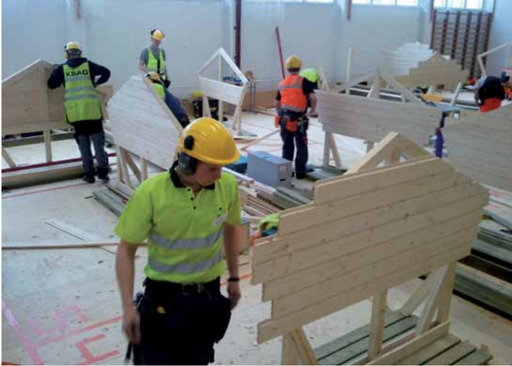
Kirvestyön semifinaalin kilpailijat työn touhussa rakennustyösalissa.
